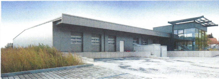
Zur weitgespannten Halle für die Produktionsküche zählt auch der Versand mit Vordach, Verladerampe und -toren.
